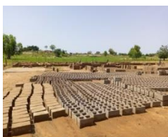
Beginn des Neubaus
